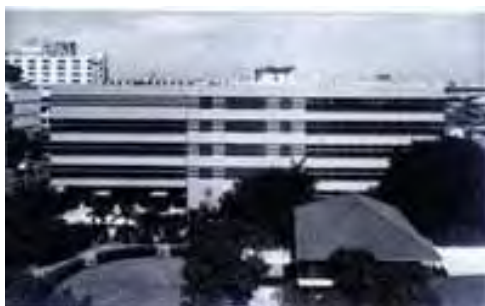
ภาพที่ 41 แสดงอาคารคอมมอนเวลท์ (มุมมองทางทิศตะวันออก )
