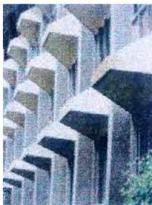
ภาพที่ 26 แสดงอุปกรณ์บังแดดคอนกรีตเสริมเหล็ก
