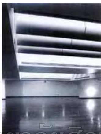
ภาพที่ 50 แสดงส่วนเกลตอร์รี่ ที่ออกแบบให้มีช่องแสงด้านบนแบบพื้นเลื่อน เพื่อให้แสงธรรมชาติเข้ามาภายในอาคาร
